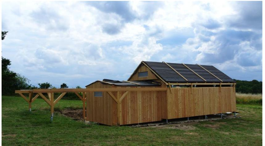
Berge liegt am Jakobsweg, in der Katastralgemeinde Au. Die gesamte Sternwarte mit Rolldachkonstruktion ist in Holzbauweise auf Schraubfundamenten errichtet. Ausschließlich die Fundamente für die Teleskopsäulen sind in Beton ausgeführt.
