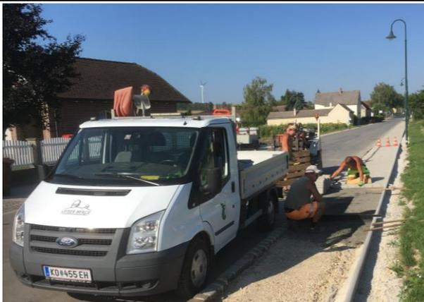
Nach dem endgültigen Abschluss aller Einbauten in der Hirschmillerstraße, wie Niederspannungs- und Gasleitungen sowie die Glasfaserverrohrung, wurde durch unsere Gemeindemitarbeiter am gesamten Gehsteigbereich, auf einer Streckenlänge von etwa 700 Laufmeter und zirka 1090 m<sup>2</sup>, die Pflasterung fertiggestellt.
