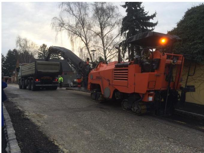
Bis Ende Oktober erfolgte in der E-Werkgasse die Neuverlegung der Gasleitung sowie die gewünschten Gas-Hausanschlüsse. Ebenfalls wurden der Gehsteig sowie die Nebenanlagen mit Schrägbord neu angelegt und die gesamte Fahrbahn der E-Werkgasse bis zur Kreuzung Johann Hannngasse neu asphaltiert.
