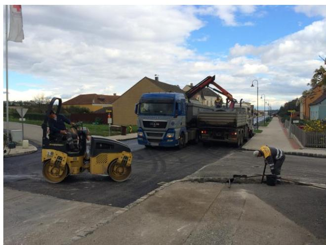
Weiters wurde in der Grafengasse die Gasleitung teilweise erneuert und die Gas-Hausanschlüsse neu verlegt. Auf der gesamten Straßenslänge, vom Marktplatz bis zur Dreikreuzgasse, sind die Randsteine erneuert, saniert und die Fahrbahn neu asphaltiert worden. Die Nebenanlagen und Abstellflächen werden im Frühjahr 2015 fertiggestellt und die Humusierung der Grünflächen durchgeführt.
