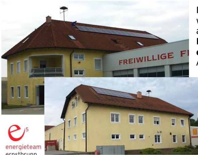
Daher werden zur Zielerreichung bis Mai 2019 weitere **vier Photovoltaikanlagen** zur Grundlastabdeckung des Strombedarfes an den Dächern der **Freiw. Feuerwehr Ernstbrunn 8KWp**, **Merkersdorf** und **Thomasl (4KWp)** sowie eine 16KWp PV-Anlage für die **NÖ Mittelschule** installiert.
