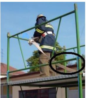
Befestigung der Löschleitung mit dem Schlauchhalter am Gerüst im markierten unteren Bereich, links oder rechts der Leiter.
